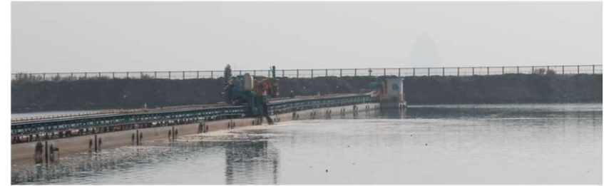
灰を埋め立てているようす
