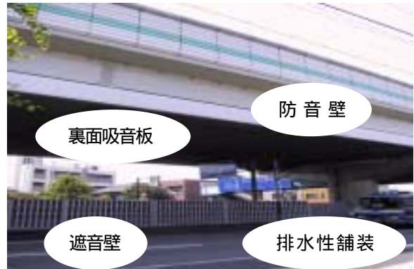
図5 中央分離帯に設置された防音壁, 裏面吸音材
