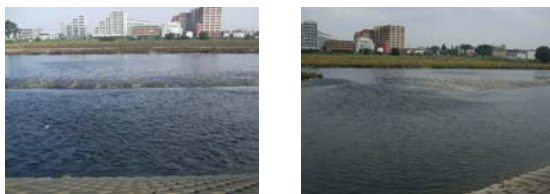
左岸に向かって 調査地点より下流 図2 多摩川原橋
