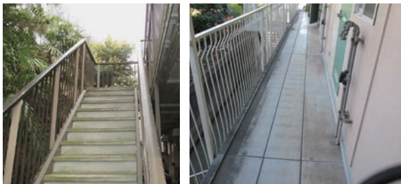
外廊下、外階段：押出成形セメント板
