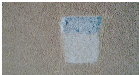
石綿含有仕上塗材の例：じゅらく壁（製造時期：1972～1988）など
