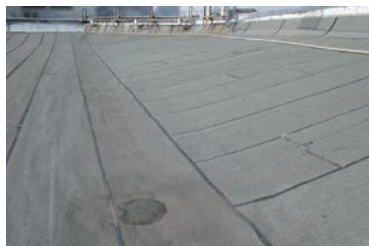
屋上防水：ルーフィング
