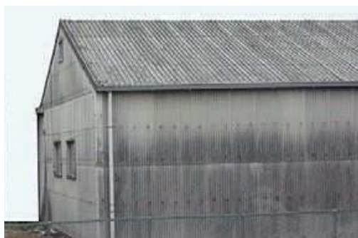
外壁・屋根：スレート波板
