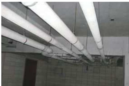
給排水管：セメント円筒管
