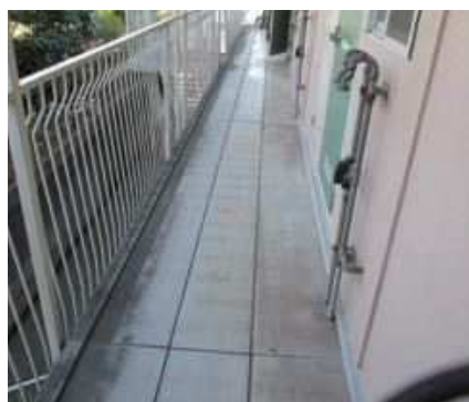
外廊下、外階段：押出成形セメント板
