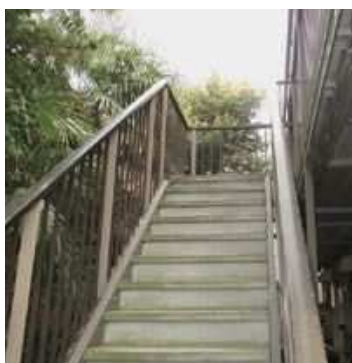
外廊下、外階段：押出成形セメント板
