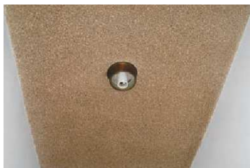
天井：ひる石（吹付け石綿）
