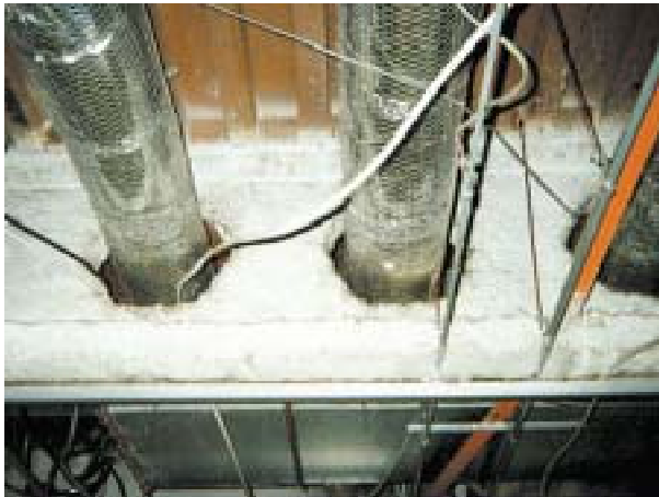
吹付けアスベスト・アスベスト含有吹付けロックウール (鉄骨造の耐火被覆)
