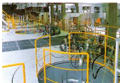
脱塩脱硫反応塔
