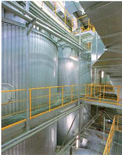
脱塩脱硫反応塔
