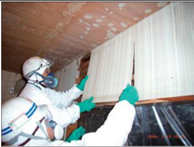
除去した成形板は手渡しで降ろす
