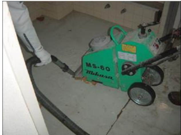
HEPAフィルタ付真空掃除機を使用しながらのビニル床タイル除去作業
