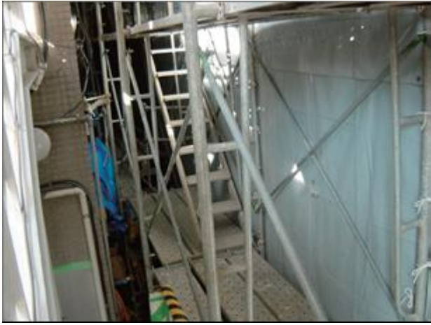
作業場外周の養生
