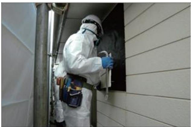
除去した成形板は手渡しで降ろす
