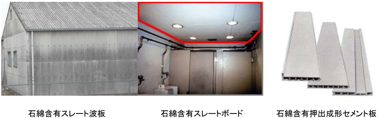
図3 非飛散性アスベスト建材例
