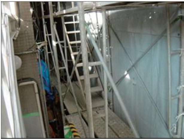
作業場外周の養生
