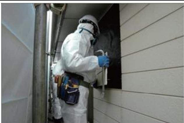
除去した成形板は手渡しで降ろす
