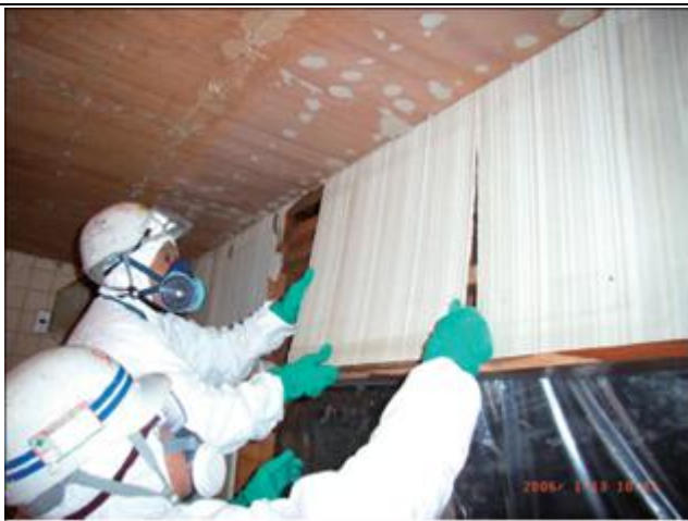
除去した成形板は手渡しで降ろす
