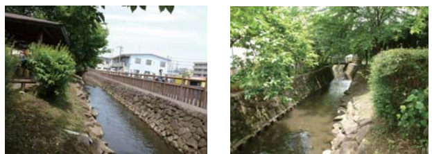
調査地点より上流 調査地点より下流
