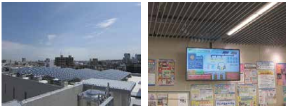
幸区役所／太陽光発電設備と屋内で確認できる発電量モニタ
