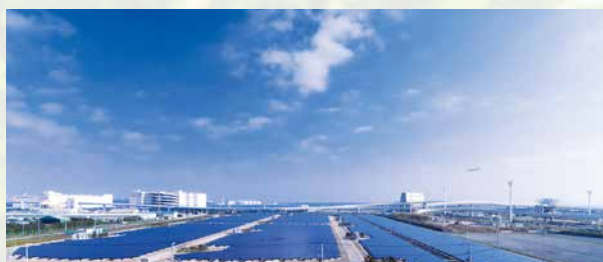
浮島太陽光発電所
