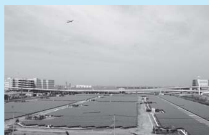
浮島太陽光発電所(メガソーラー)
