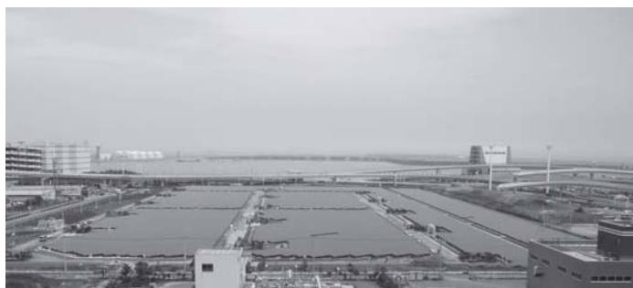
【浮島太陽光発電所】(平成23年8月10日稼働)
