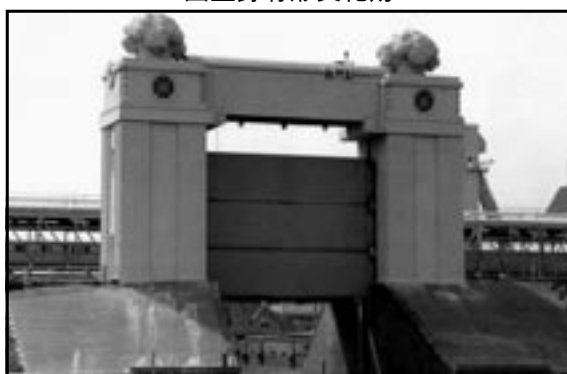
川崎河港水門
