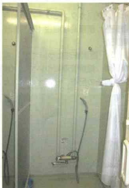
ポリマーセンター 男性シャワールーム
