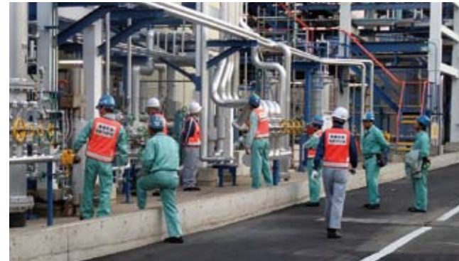
グループ各社による設備点検
