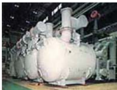
ガス絶縁変圧器
