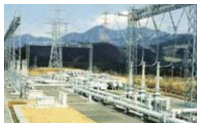
開閉装置の更なる縮小化を実現し、自然と調和した大容量550kV 8kA GIS*3
