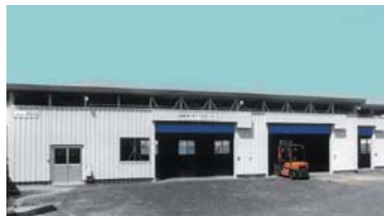
リサイクルセンターの外観
