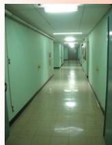
24時間体制で操業しているごみ焼却施設（橘処理センター）の制御室の蛍光灯照明を直管型LED照明に置換え、全般照明としての実用性を検証しました。一方、通路（写真左）の天井に、人感調光センサー付きのLED照明を設置し、調光による消費電力削減効果を検証しました。
