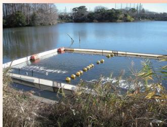
水中ポンプを設置し、研究フィールドの向かって奥の池水を手前の散水装置から放流することにより水を循環させ、酸素を水域に供給しています。
