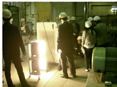
発電した電気による照明の点灯
