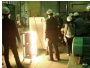
発電した電気による照明の点灯
