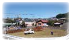
整備直前の状態
