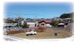
整備直前の状態
