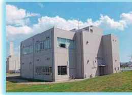
③大師河原干潟館 (大師河原水防センター)
