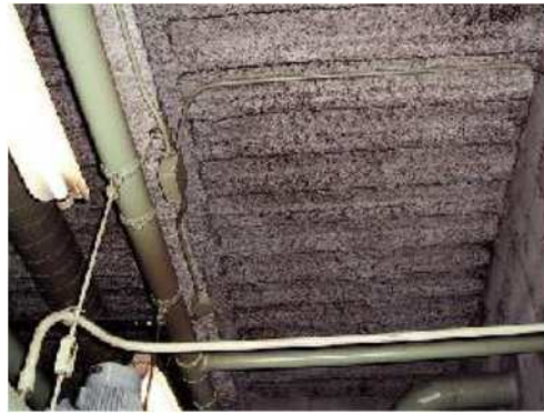
(写真2) 吹付けロックウール
