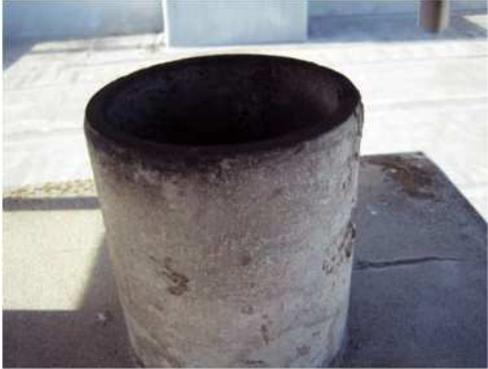
(写真3) 煙突断熱材
