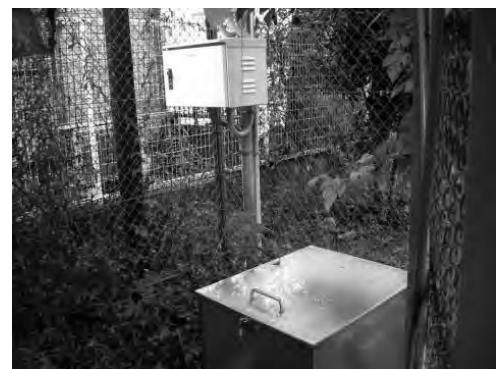
地盤沈下観測所の水位計
