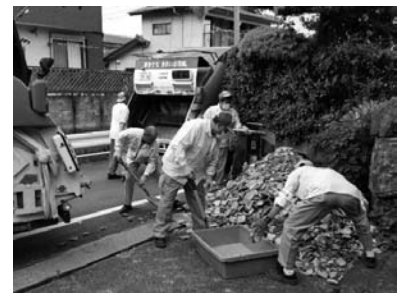
【熊本での作業の様子】
