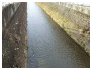
C. ほぼ全面がコンクリートになっている
