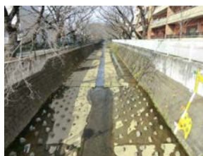
C. ほとんど流れていない、水が枯れている
