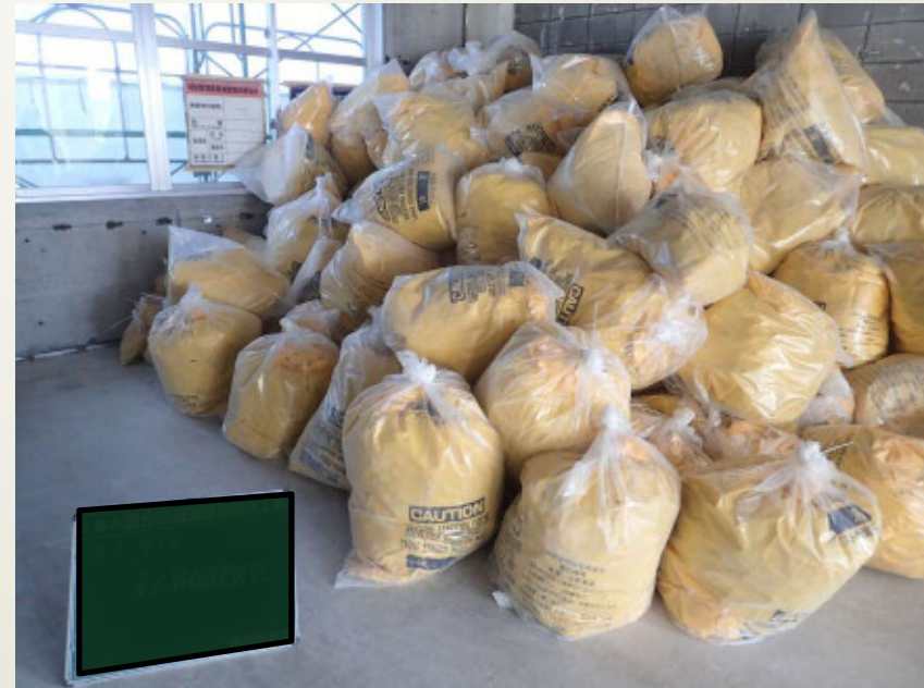
アスベスト保管状況 二重梱包
