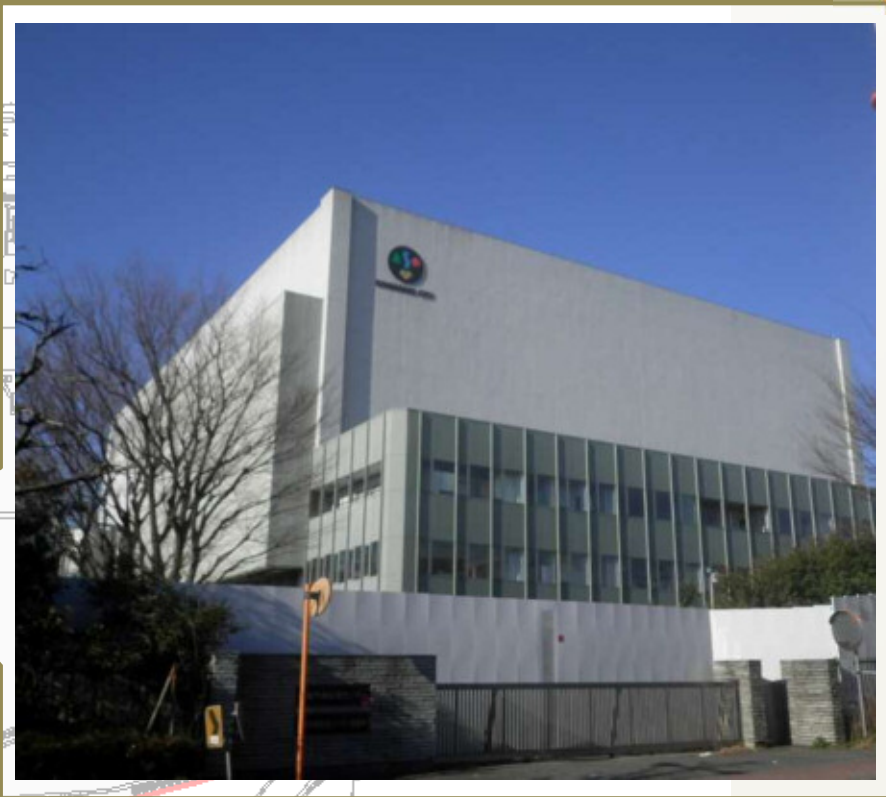
ごみ焼却処理施設 【200t/24h×3基 (連続燃焼式ストーカ炉)】
