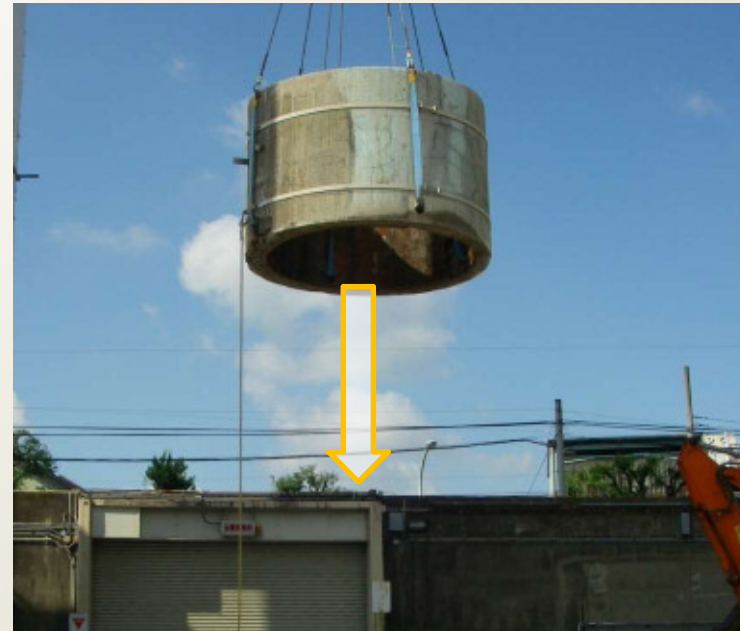
切断煙突吊り下ろし
