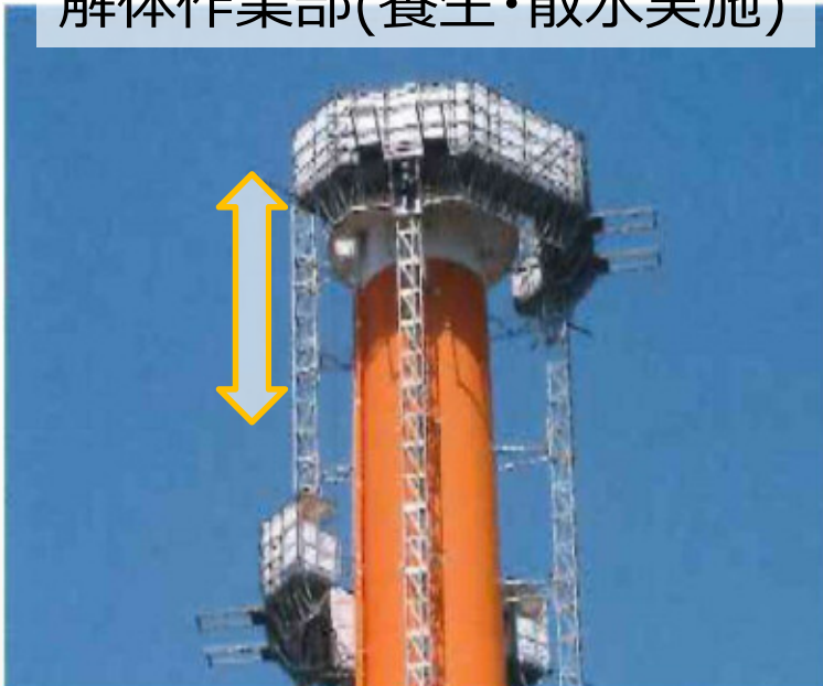
煙突上部解体状況
