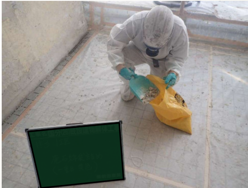
アスベスト除去・梱包状況 一重目
