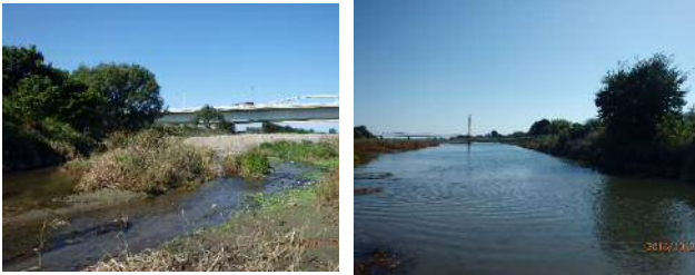
上流側 下流側 図2 多摩川本川 多摩川原橋
