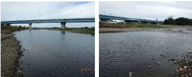
上流側 下流側 図3 多摩川本川 二子橋
