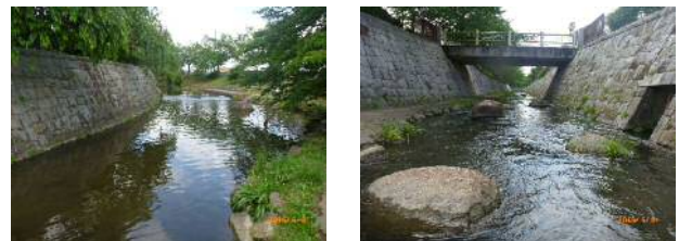
上流側 下流側
