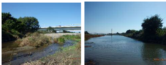
上流側 下流側
