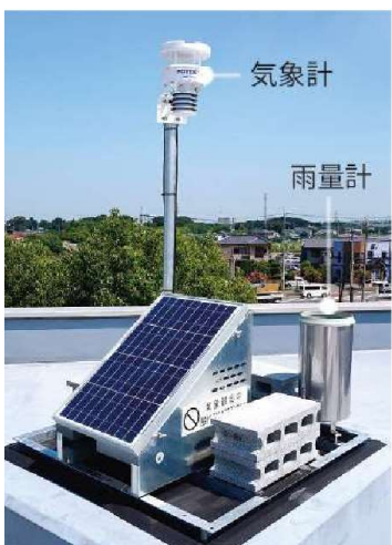
POTEKA設置の様子
