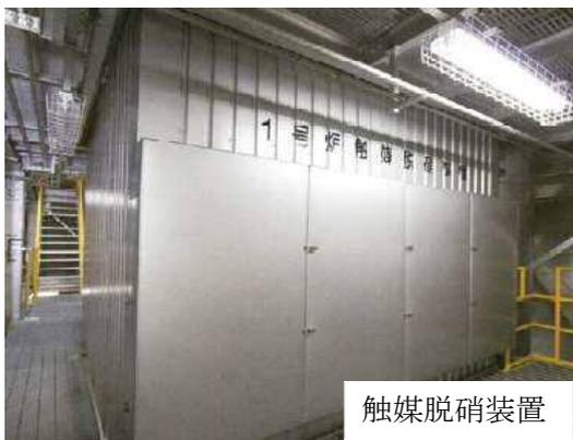
触媒脱硝装置
