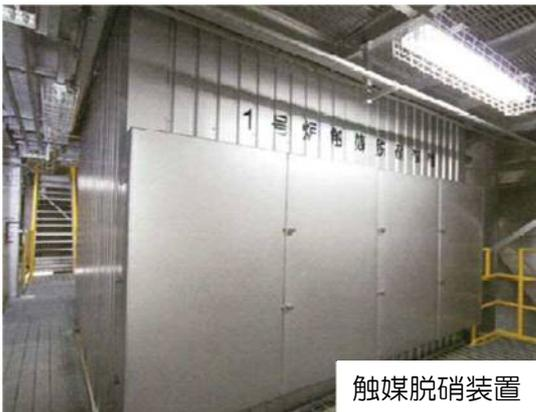
触媒脱硝装置
