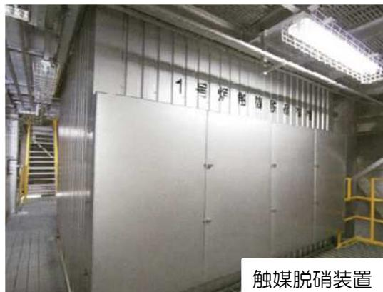
触媒脱硝装置
