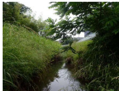
図3 三沢川 下村橋
