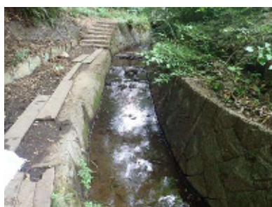
図6 平瀬川 初山水路
