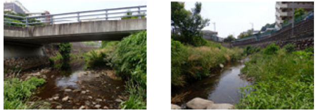
図3 平瀬川支川下長沢橋
