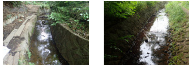
図4 平瀬川初山水路
