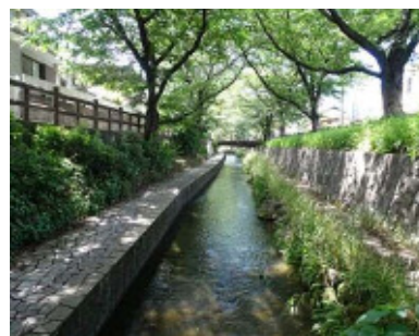
図7 ニヶ領用水宿河原線 北村橋
