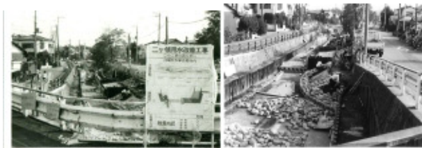
図1 1984年当時の市内護岸工事の様子
