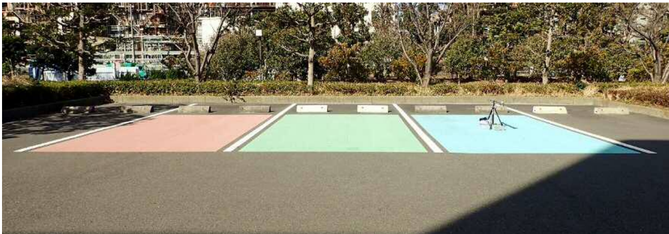
図8. 1年半経過時塗装状況（2019年2月）
