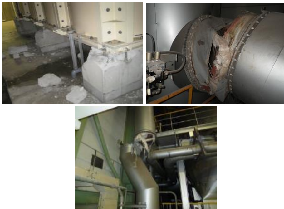
図3-6 廃棄物処理施設の被害状況（提供：熊本市）
