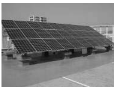
太陽光発電設備 (麻生区役所)
