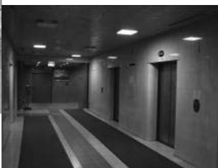
第3庁舎エレベーターホール LED照明
