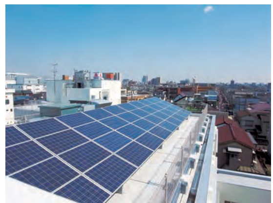
太陽光パネル
