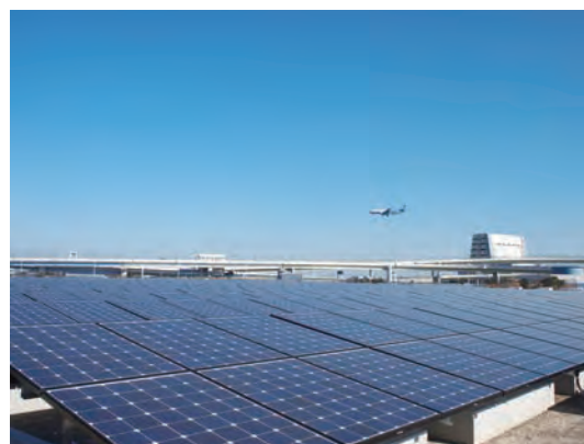
隣接する浮島太陽光発電所
