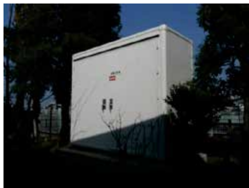
蓄電池（上作延小学校）
