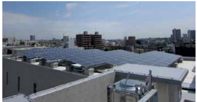
幸区役所に導入した太陽光発電設備
