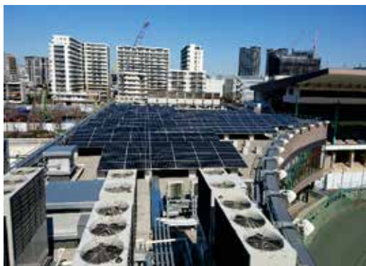
太陽光発電設備（川崎競輪場）
