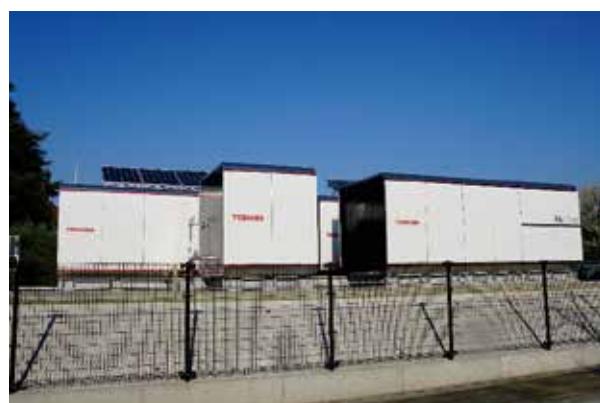
再生可能エネルギーと水素を用いた自立型エネルギー供給システム「H2one」
