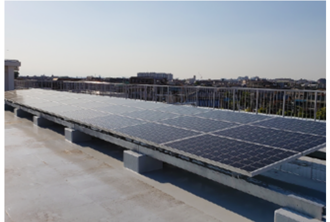
登戸小学校に導入した太陽光発電設備
