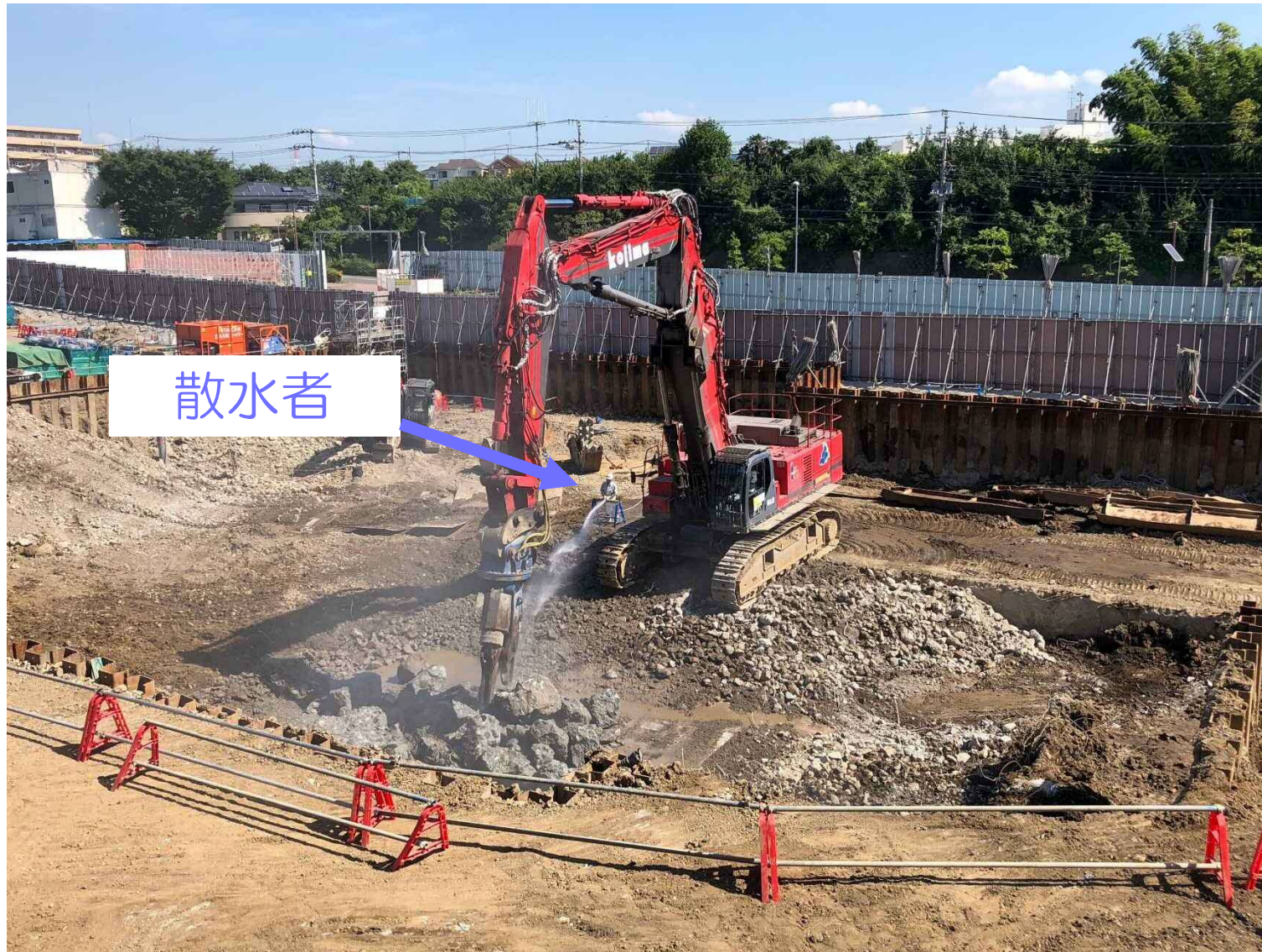
粗大ごみ処理施設解体状況
