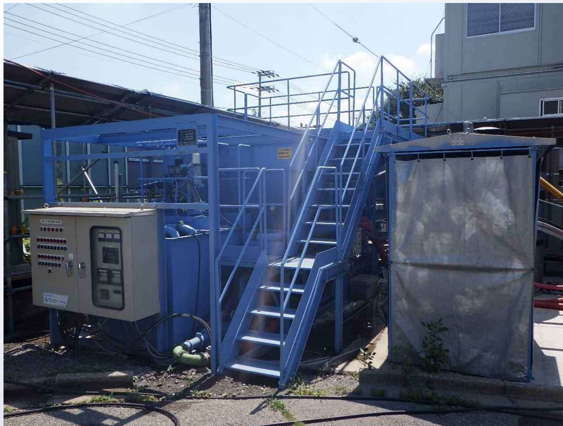
排水処理設備
