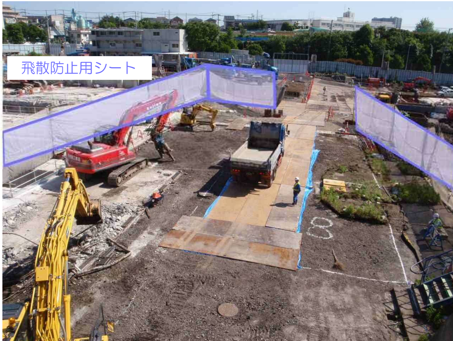
土壌汚染対策状況
