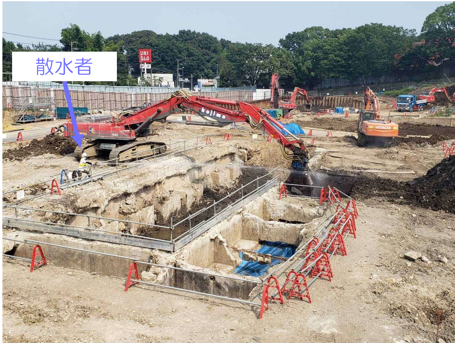
ごみ焼却処理施設解体状況
