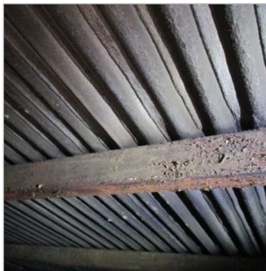
折板屋根断熱材
