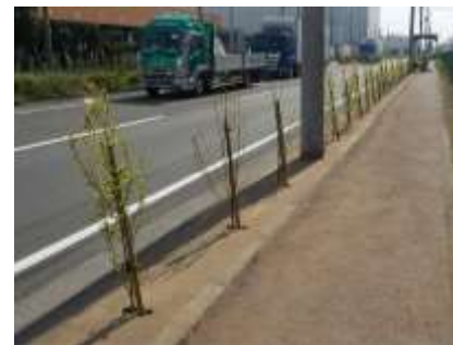
東扇島1号線沿道環境整備工事
