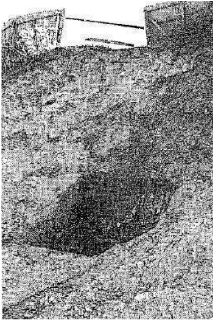
図6-6 廃石綿等の埋立用穴
