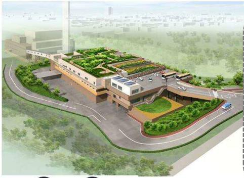
旧施設の老朽化に伴い建替を行い、平成24年3月に竣工。市内北部のごみ処理の基幹的役割を担い、焼却に伴い発生する廃熱を利用した高効率発電設備を設け、公害防止等の面からもこれまでに無い厳しい基準値をクリアできる高度な設備を有し、低炭素社会の構築や環境保全に寄与する施設となっています。
