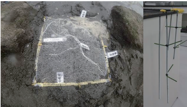
図1 都市型被覆網及び鉄筋杭の設置状況と設置前の鉄筋杭
