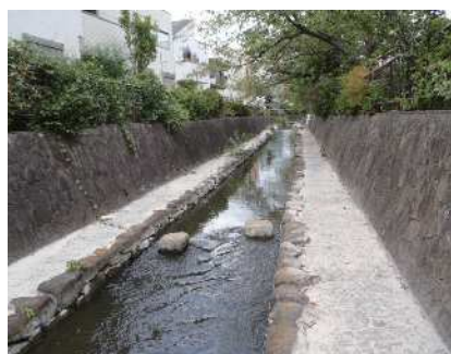
【岸辺のある川：道路上にすぐ上がる場所がない】
