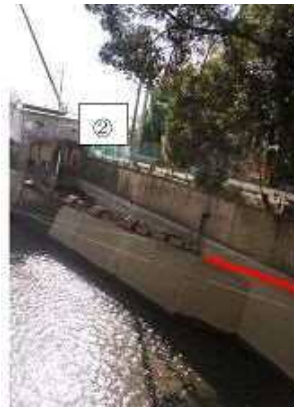
図13 工事中の円筒分水の状況 その1
